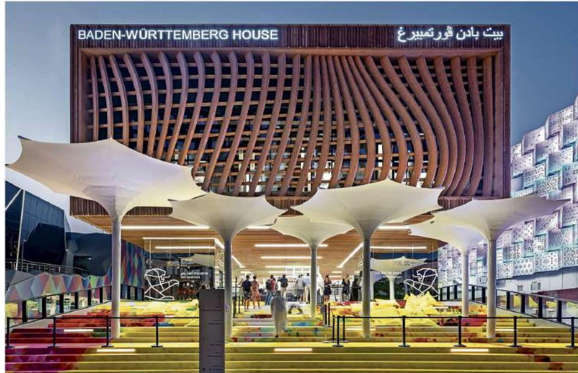
*Das Baden-Württemberg-Haus auf der Expo in Dubai beeindruckt durch seine Architektur: ein freischwebend wirkender, dreigeschossiger Korpus mit einem Hybrid-Tragwerk aus Holz und Stahl. Die Lamellen der Holzfassade sind eine Anlehnung an die traditionelle arabische Bauweise. FOTO: CATALIN MARIN*
